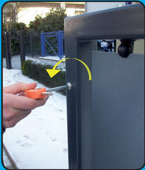
1. Dévissez d'un tour les trois vis sur la battée du portail à l'aide d'une clé Allen de 6 mm.
